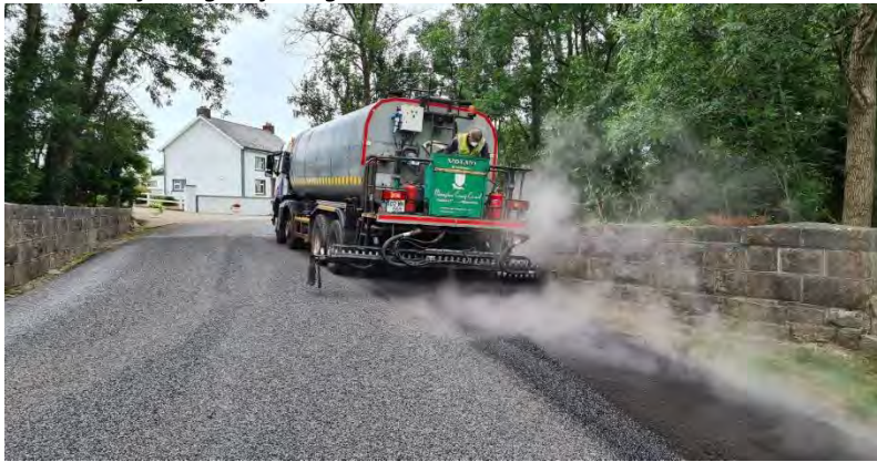
Fíor 2: cóirithe le dromchla faoin gclár Cothabháil Athchóirithe 2021
