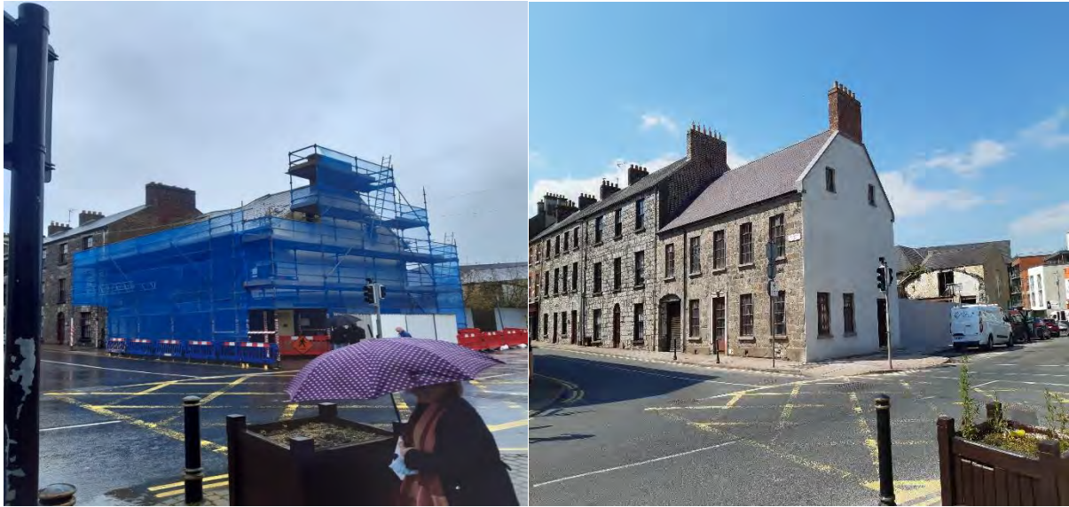
4/5 Sráid an Mhulinn – Oibreacha Cobhsaíochta Éigeandála
