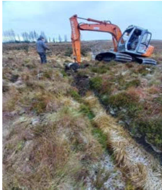
Sa phictiúr: Damba móna a chruthú chun draein a bhlocáil ar Shliabh Beagh chun feidhmeanna hidreolaíocha an bhratphortaigh a athbhunú.
